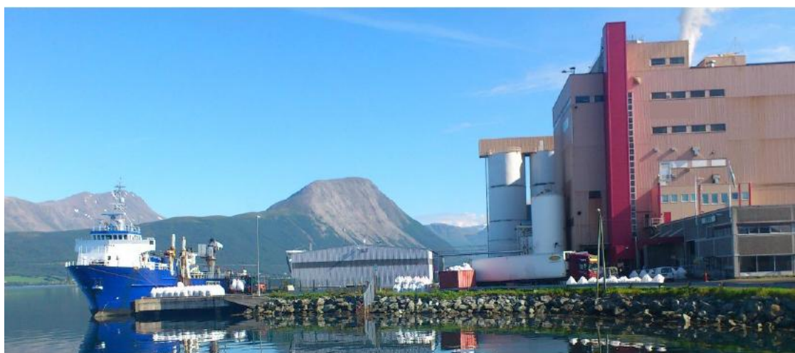
Figur 7 Cargill Bergneset. Forfabrikk. Foto: Transportutvikling AS
