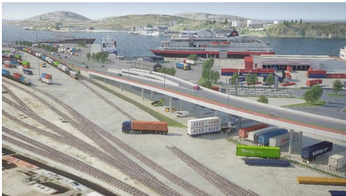
Figur 19 Illustrasjon av ønsket løsning med jernbaneveien løftet over terminalområdet på Bodøterminalen
