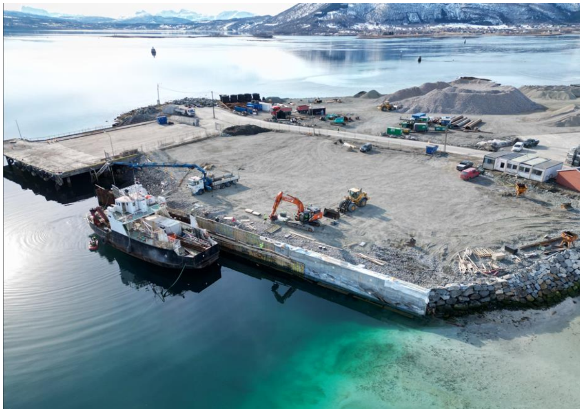
Figur 12: Dronefoto utført av Vinter Entreprenør april 2024
