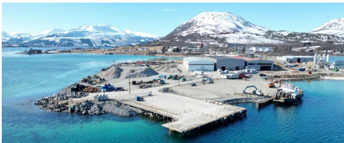
Figur 11: Utbedring av kai mot øst . Dronefoto utført av Vinter Entreprenør april 2024
