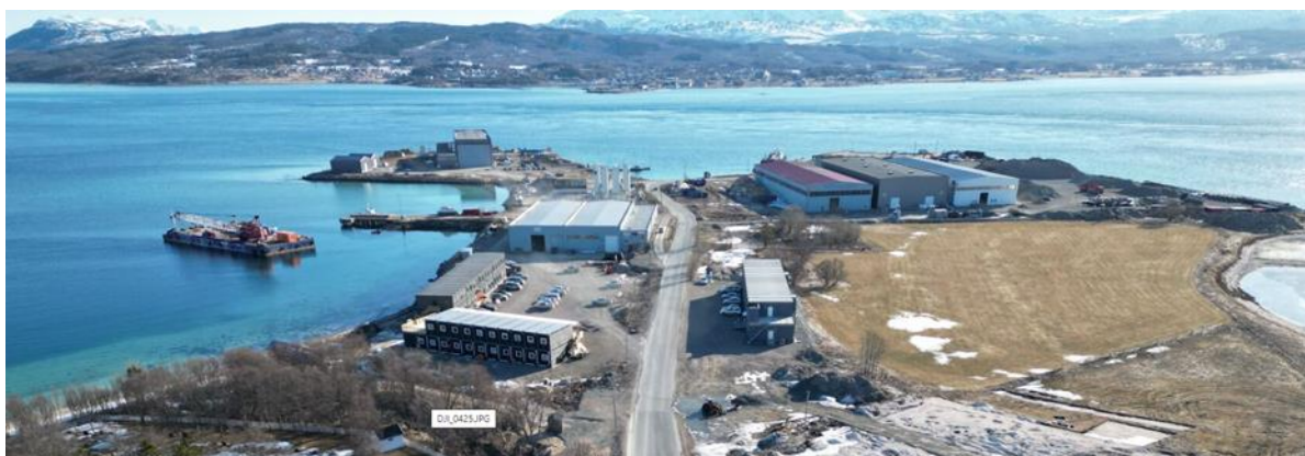
Figur 21: Dronefoto utført av Vinter Entreprenør april 2024
