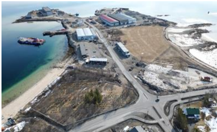
Figur 2: Dronefoto tatt av Vinter Entreprenør april 2024
