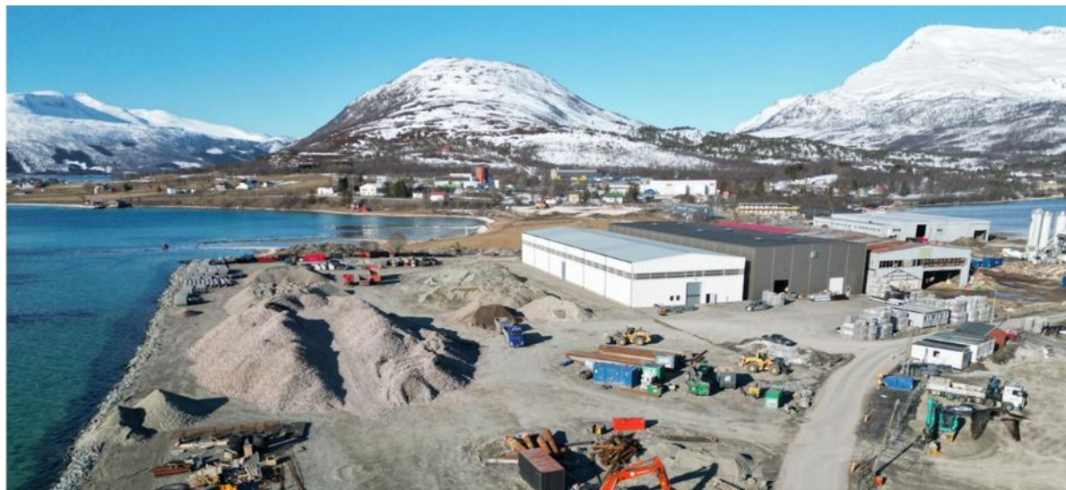
Figur 22: Dronefoto utført av Vinter Entreprenør april 2024
